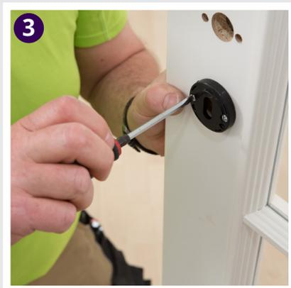
3 Setze von beiden Seiten die Trägerrosette in die Bohrungen ein und verschraube diese miteinander.
