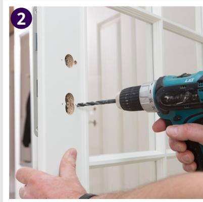
2 Bohre mit einem Holzbohrer jeweils an den vier markierten Punkten Löcher.
